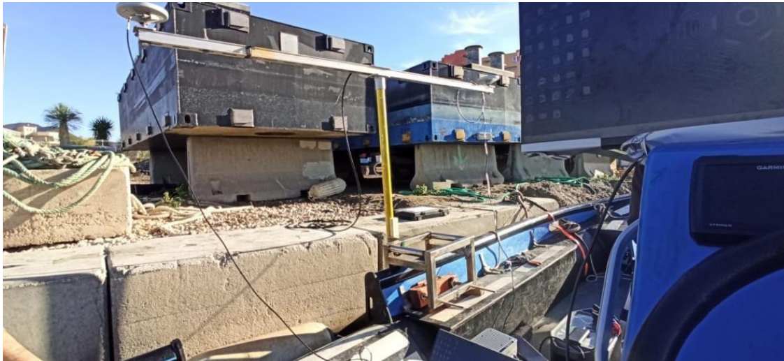
Figura 6: Construcción de las antenas GN.
